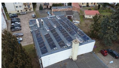
Wymiana źródła ciepła w budynku wielorodzinnym przy ul. Poznańskiej 29
