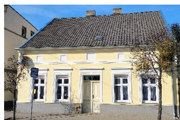
Remont budynku mieszkalnego przy ul. Kościuszki 7
