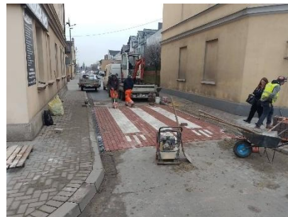
Wykonanie wywyższonego przejścia dla pieszych na ul. Długiej w Nowym Tomyślu
