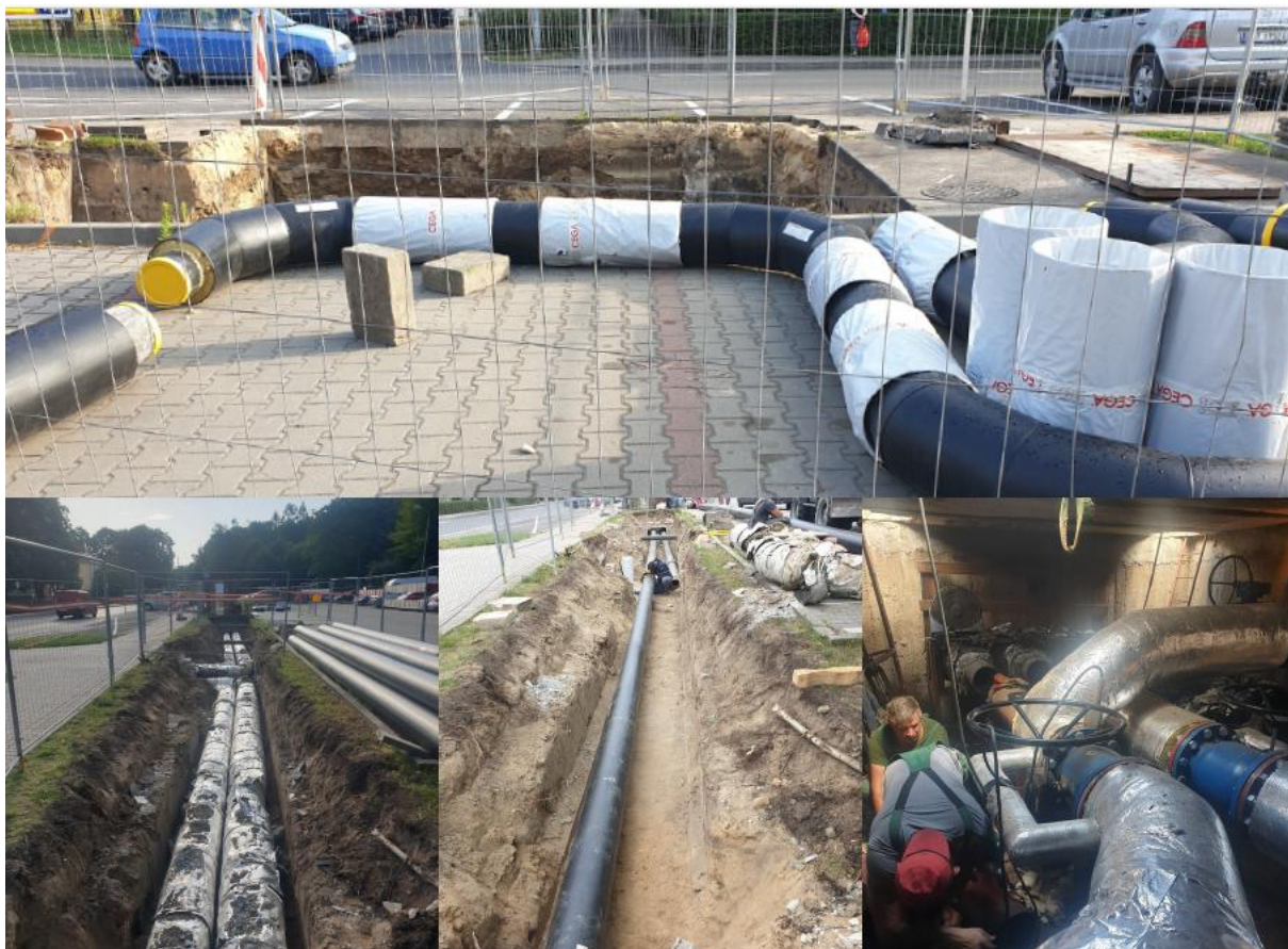
Przebudowa sieci ciepłowniczej od komory K-18 do K-18A w obrębie ul. Stanisława Musiała
