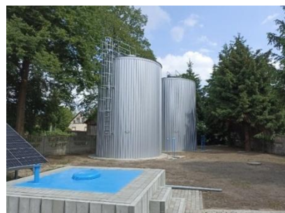
Budowa dwóch zbiorników terenowych wody uzdatnionej o pojemności V= 100 m 3 w ramach przebudowy stacji uzdatniania wody w Sątopy
