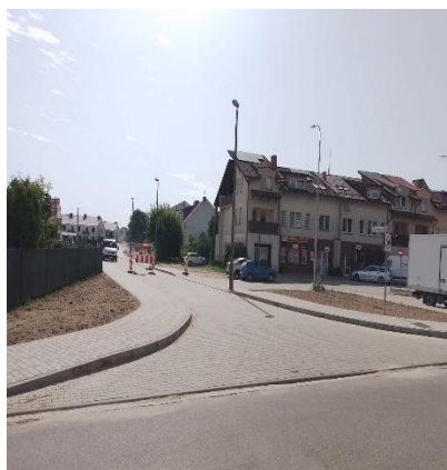
Budowa ul. Świerkowej w Nowym Tomyślu
