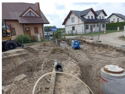
Budowa kanalizacji sanitarnej w ul. Grudniowej w Glinie
