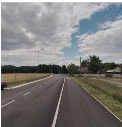
Budowa ul. Leśnej w Nowym Tomyślu i Paproci
