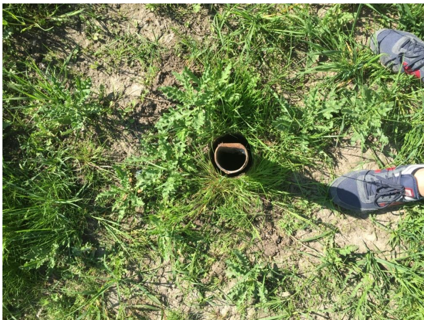
Fot. 2. Piezometr P-8 – widok na wnętrze kolumny filtracyjnej
